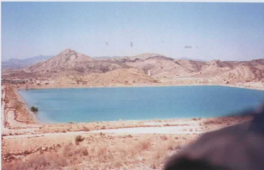
Embalse Regulador La Serreta (Comunidad de Regantes El Canalillo de Agost)
