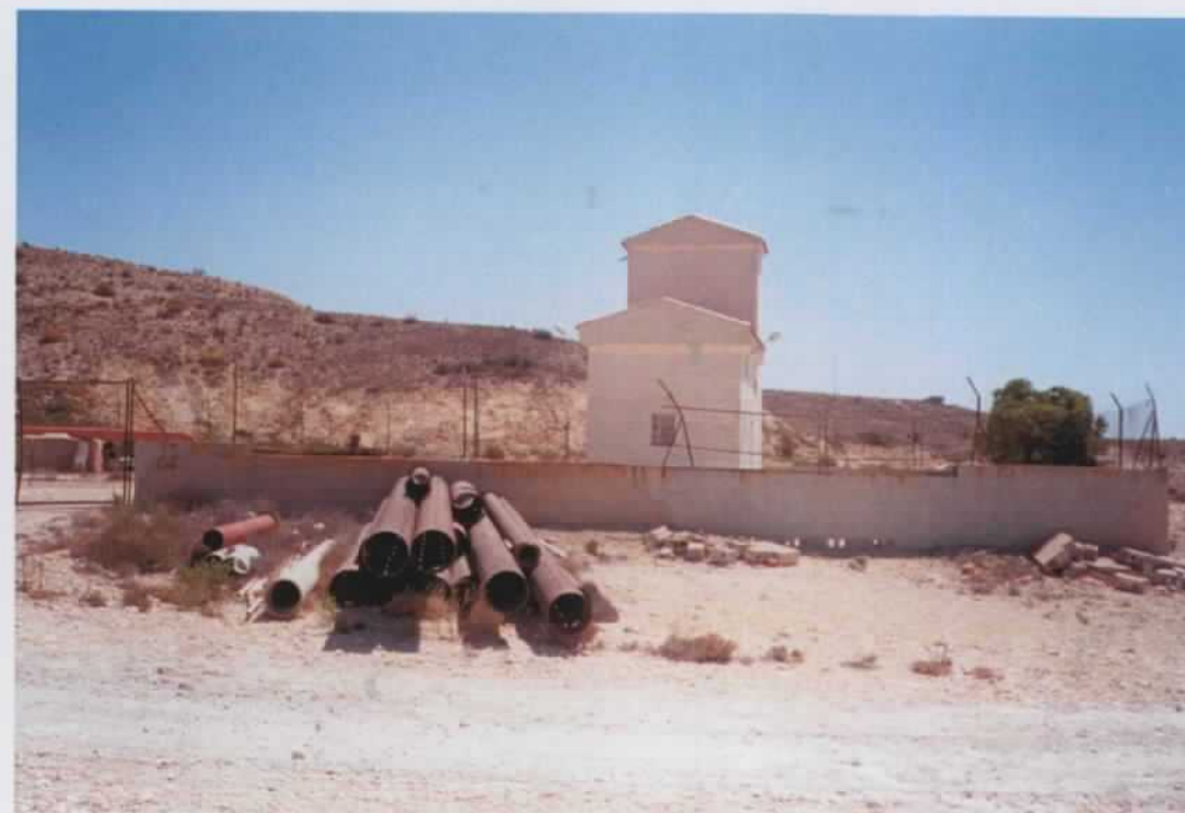
Sondeo La Serreta (Comunidad de Regantes El Canalillo de Agost)
