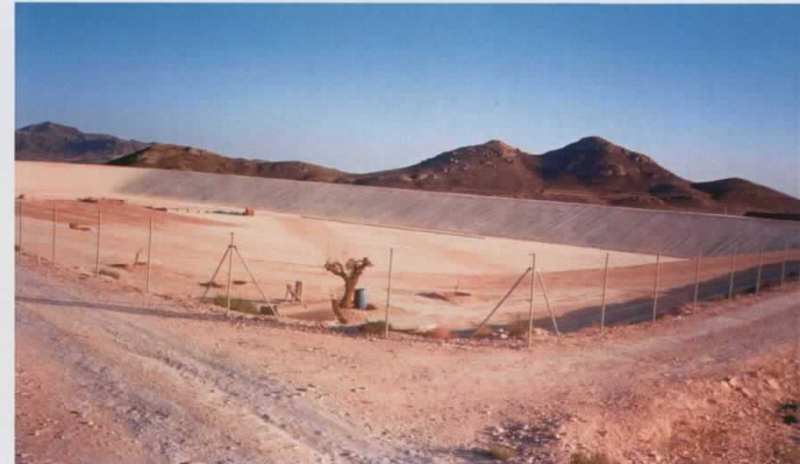
Embalse regulador en construcción (Comunidad de Regantes El Canalillo de Agost)
